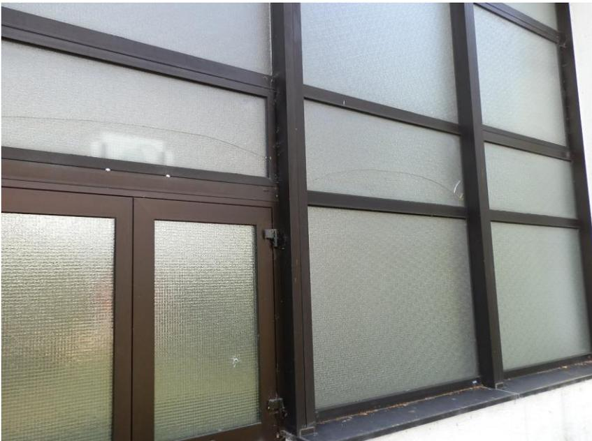
**Foto: alte, schadhafte Isolierverglasung**
