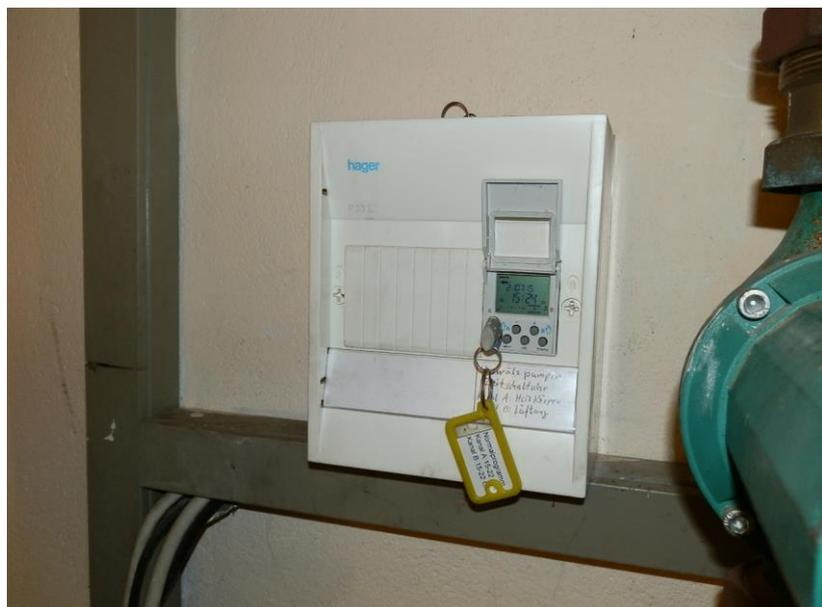
Foto: externe Zeitsteuerung für die Bereiche Heizkörper und Lüftung
