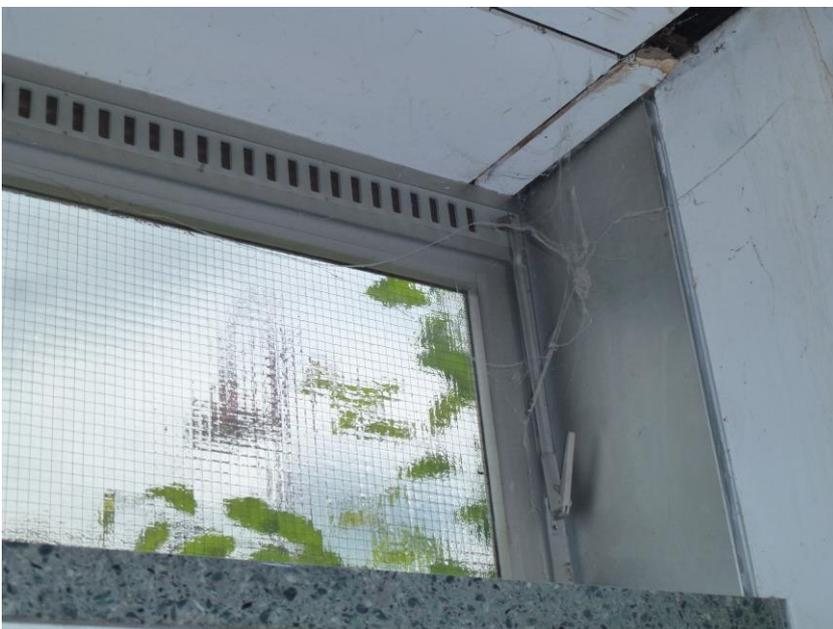
**Foto: altes Glasgitterfenster mit Zwangslüftungsschlitzen**
