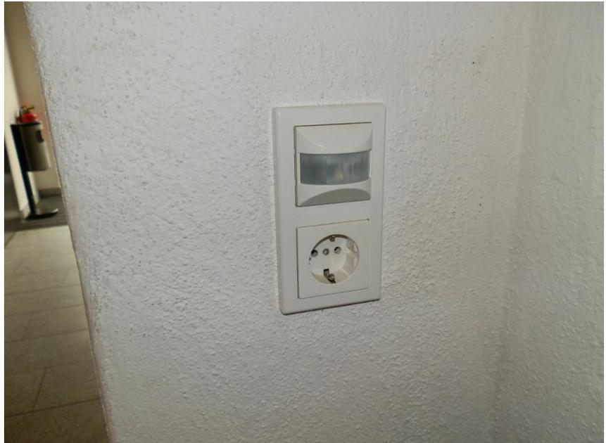
**Foto: Flur/Präsenzmelder zur bedarfsabhängigen Beleuchtungsschaltung**
