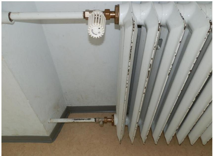
**Foto: Mehrstöckiges Gebäude/Thermostatventil mit Sollwertbegrenzung/Behördenmodell**
