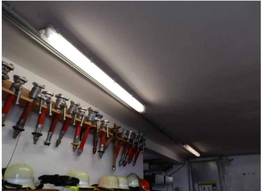
**Foto: Fahrzeuggarage/Langfeldleuchte mit T8-Leuchtstofflampe**
