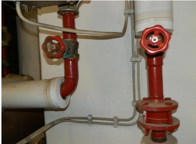
Foto: alte Absperrventile ohne Dämmung
