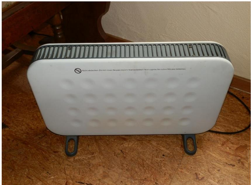
**Foto: Aufenthaltsraum OG/Elektro-Direktheizgerät**
