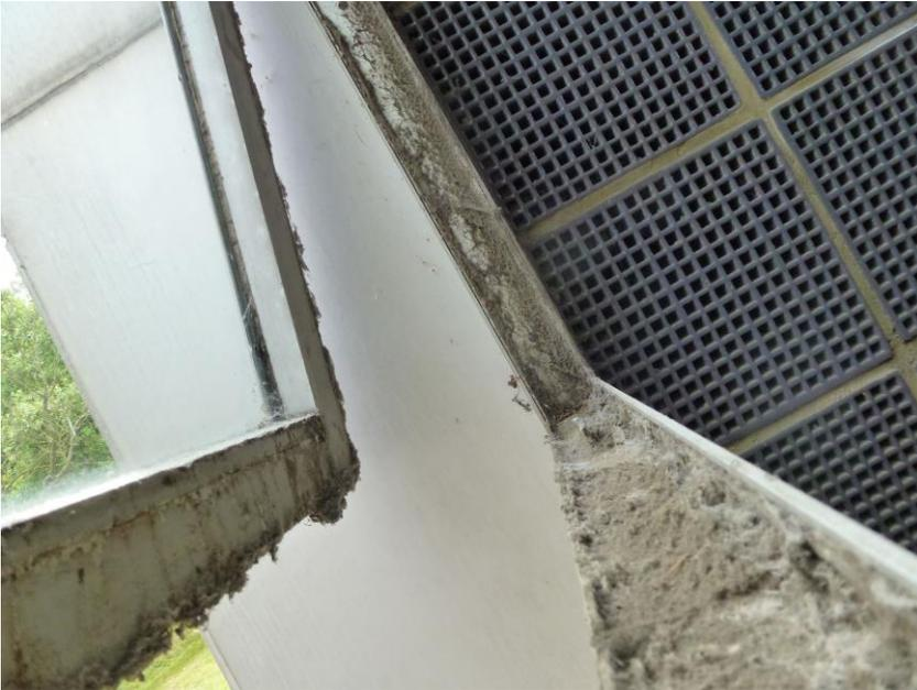
Foto: altes Fenster, einfachverglast
