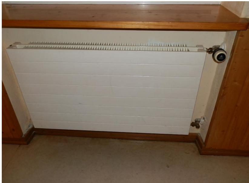
**Foto: Saal/Heizkörper mit Thermostatventil**
