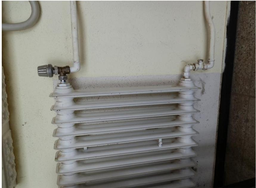
**Foto: Heizkörper mit altem Thermostatventil**
