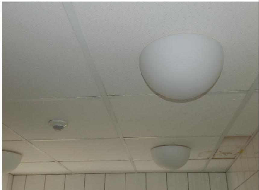
**Foto: Mehrstöckiges Gebäude/Toiletten, Leuchten mit Energiesparlampen und Präsenzmelder**
