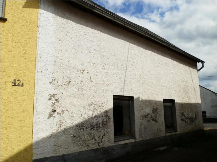
Foto: Fassade mit Feuchteschäden, Ansicht Nord
