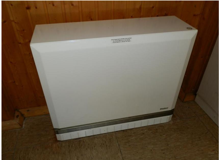
Foto: Aufenthaltsraum/neues Speicherheizgerät, Fabrikat Vaillant
