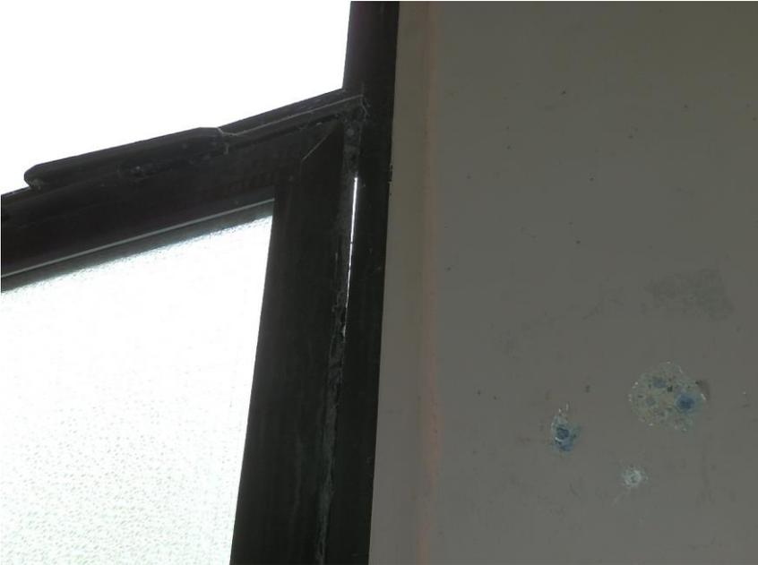
**Foto: Halle, undichtes Fenster mit großem Luftspalt**
