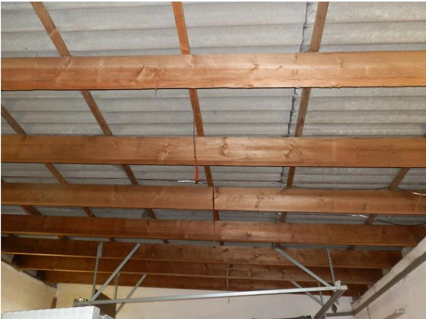
Foto: Deckenkonstruktion, nur mit Eternit-Wellplatten
