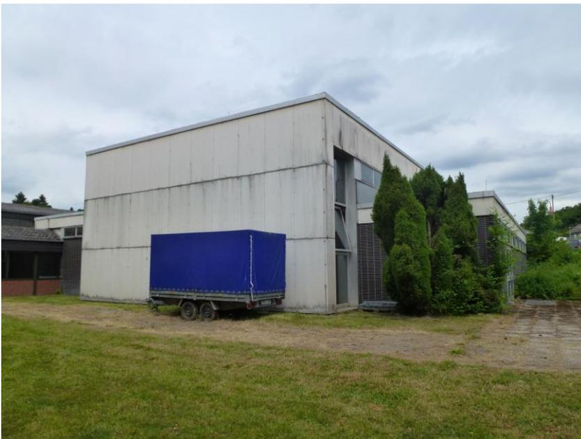
**Foto: Fassade mit Eternit, ungedämmt**
