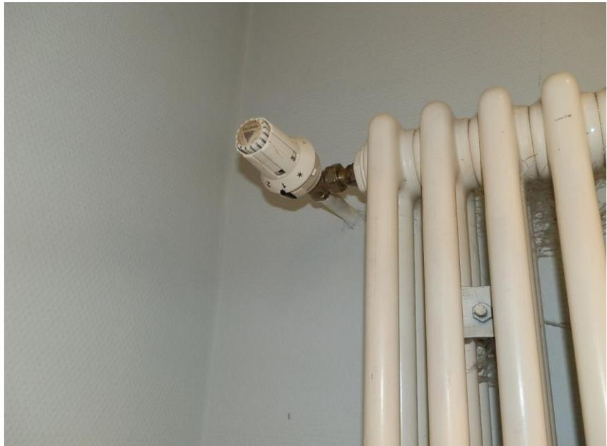
Foto: Radiator mit voreinstellbarem Thermostatventil
