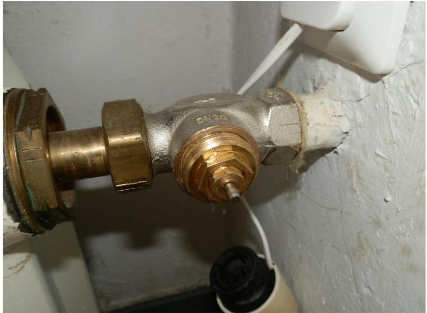
**Foto: Mehrstöckiges Gebäude/Heizkörperventil ohne Vorsteinstellung und mit elektronischem Regler**
