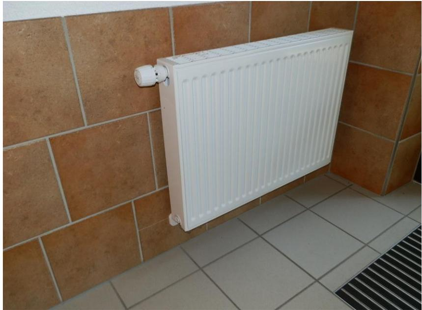
**Foto: neuer Radiator mit voreinstellbarem Thermostatventil**
