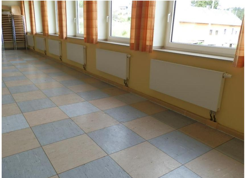
**Foto: Saal/neue Ventilheizkörper mit voreinstellbaren Thermostatventilen**
