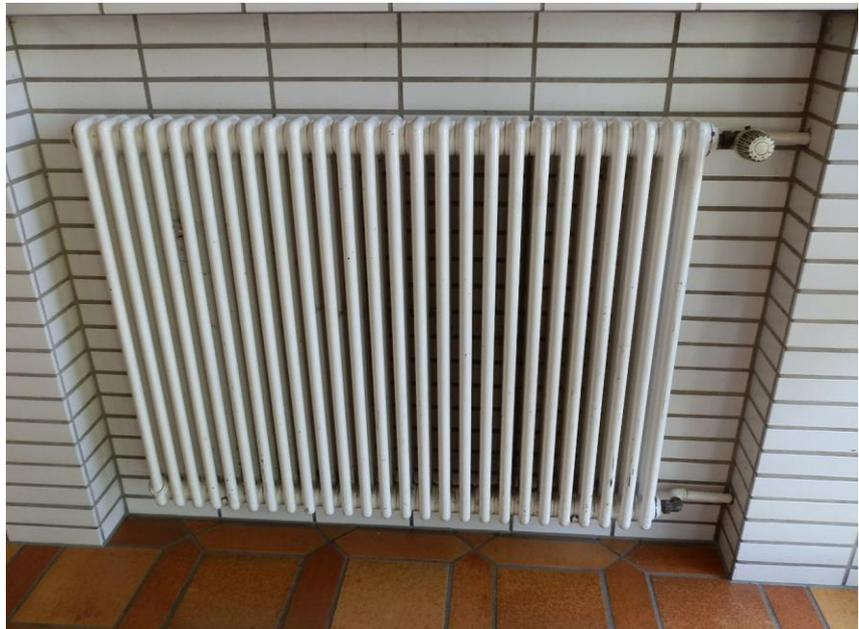
**Foto: Heizkörper mit altem Thermostatventil**
