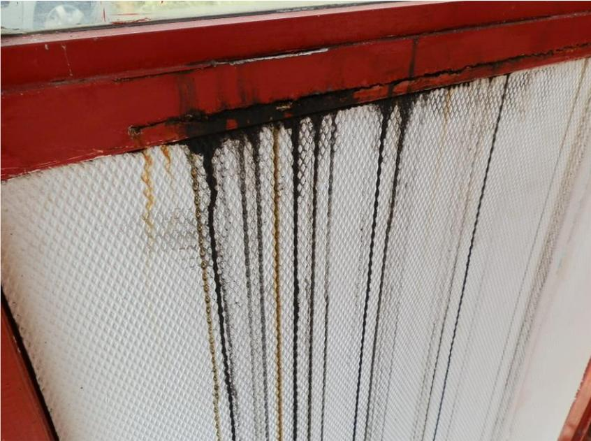
**Foto: Metalltor Fahrzeughalle/schadhaft, undicht**
