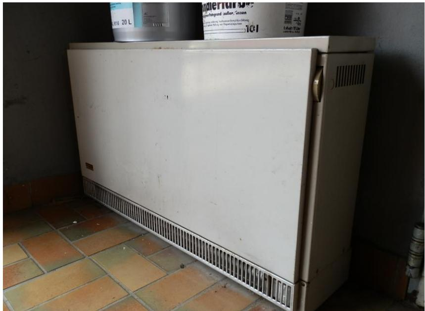
Foto: Fahrzeughalle/altes Speicherheizgerät, Fabrikat Zanker
