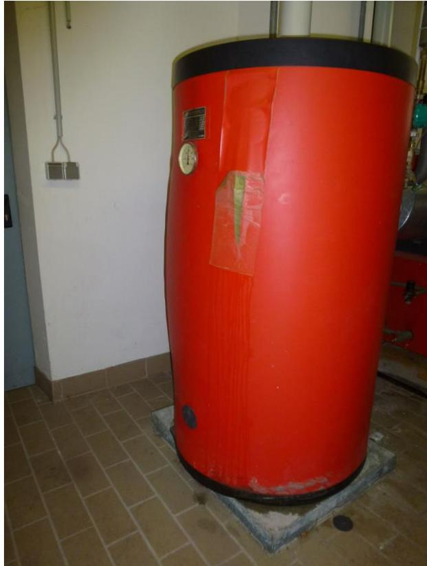
Foto: zentrale Trinkwassererwärmung
