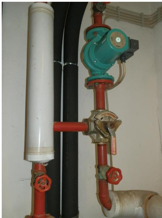
Foto: Heizkreis mit Handmischer, elektrischer Stellantrieb defekt, demontiert
