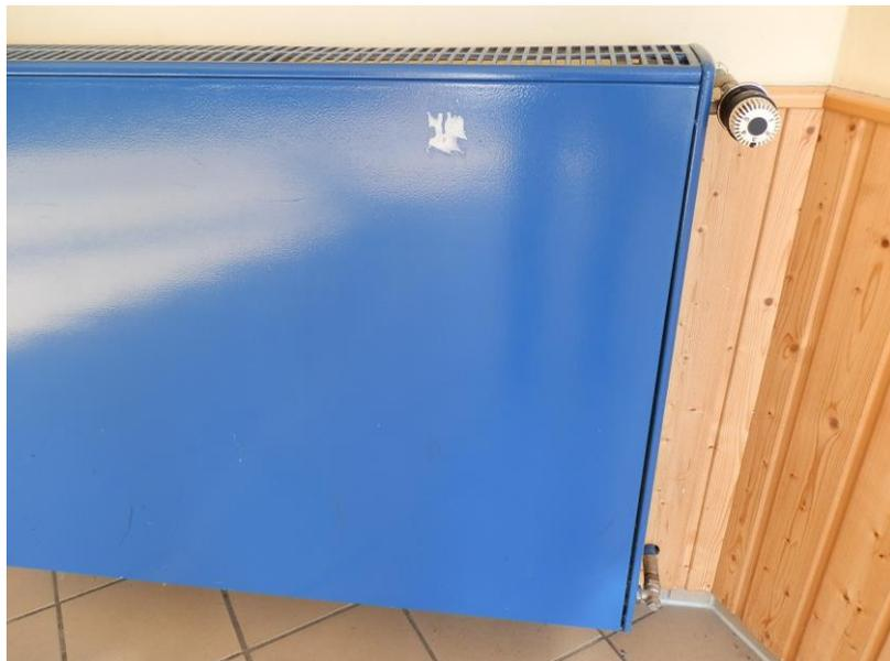
**Foto: Heizkörper mit altem Thermostatventil**
