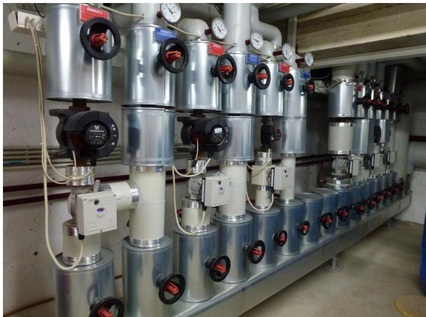
**Foto: Umwälzpumpen, Heizungsverteiler**
