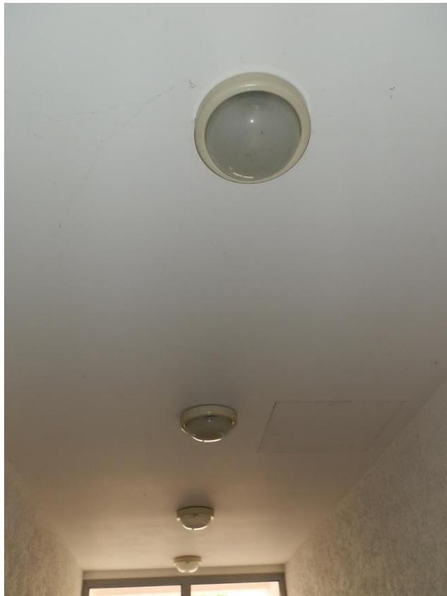
**Foto: Flur/Eingang, Deckenleuchte mit Halogenlampen**
