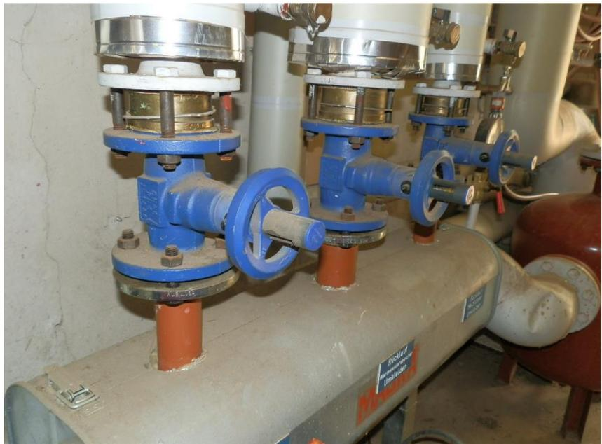
Foto: ungedämmte Absperrventile
