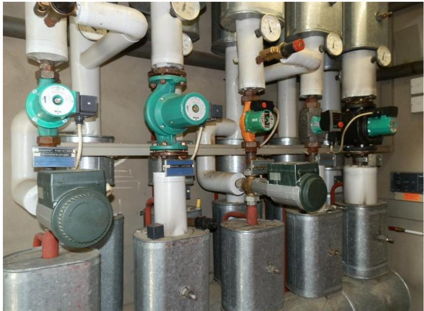
**Foto: Verteiler, Umwälzpumpen**
