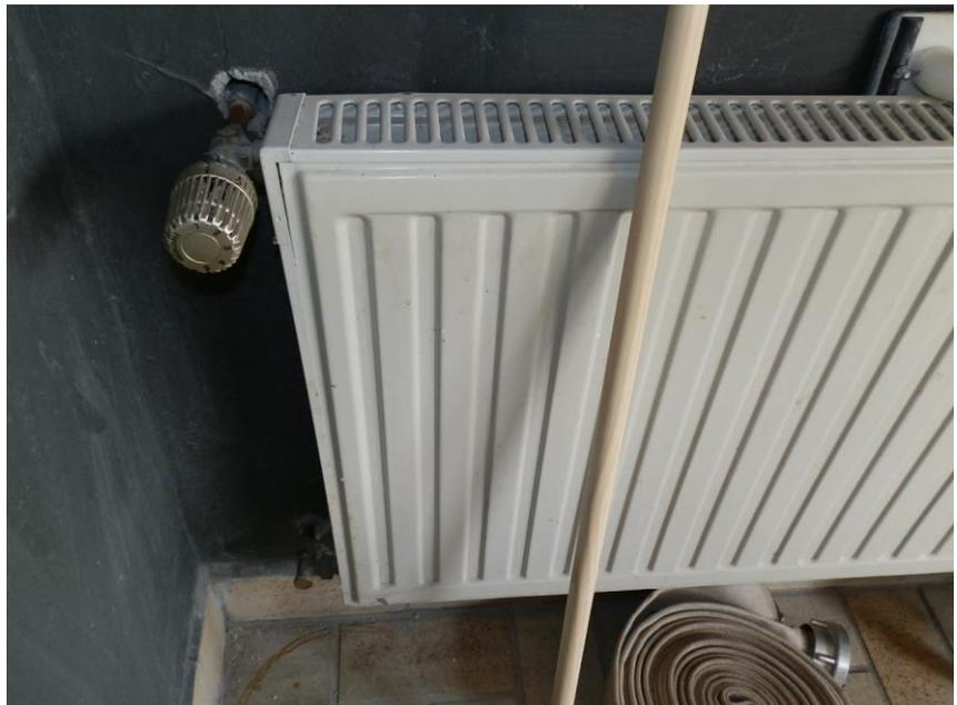
**Foto: Feuerwehrgarage/altes Thermostatventil**
