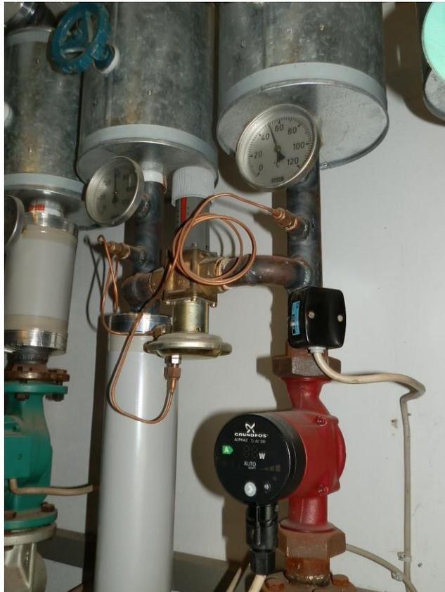
**Foto: Differenzdruckventil Heizkreis Turnhalle**
