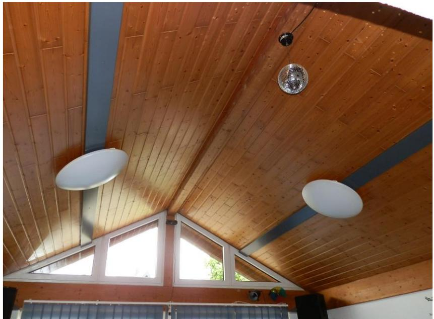
**Foto: Feuerwehr-Schulungsraum/neue Leuchten mit T5-Lampen und elektronischen Vorschaltgeräten**
