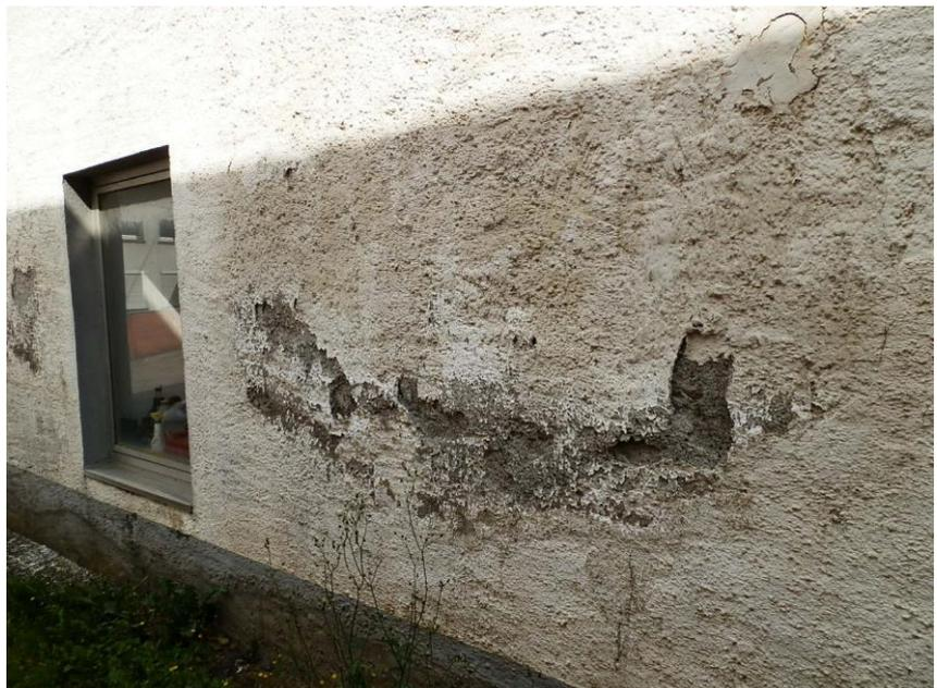
**Foto: Feuchteschäden Mauerwerk Nordseite**
