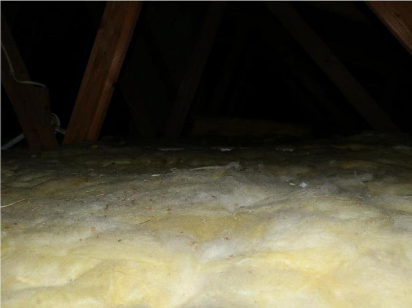
Foto: Dämmung oberste Geschossdecke
