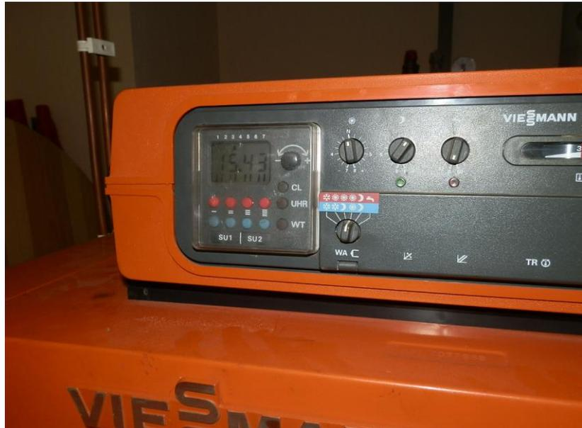
Foto: zeit- und temperaturabhängige Kesselregelung
