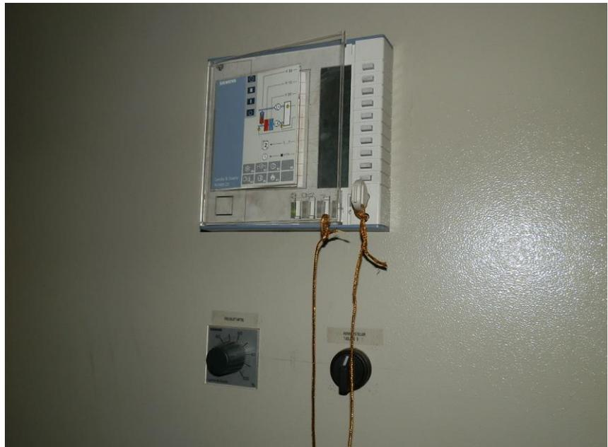
Foto: Regelgerät zur RLT-Anlage
