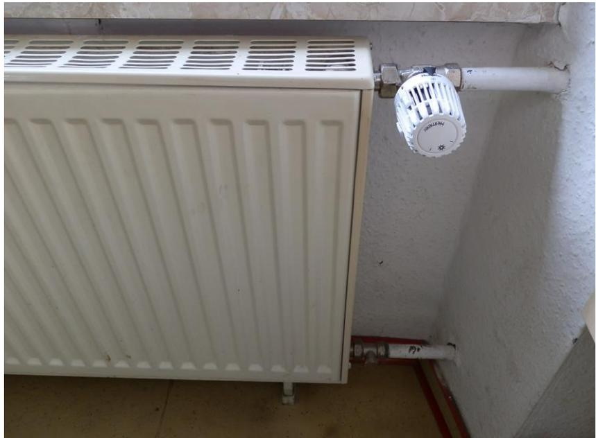
**Foto: neues Thermostatventil, hydraulisch einreguliert**
