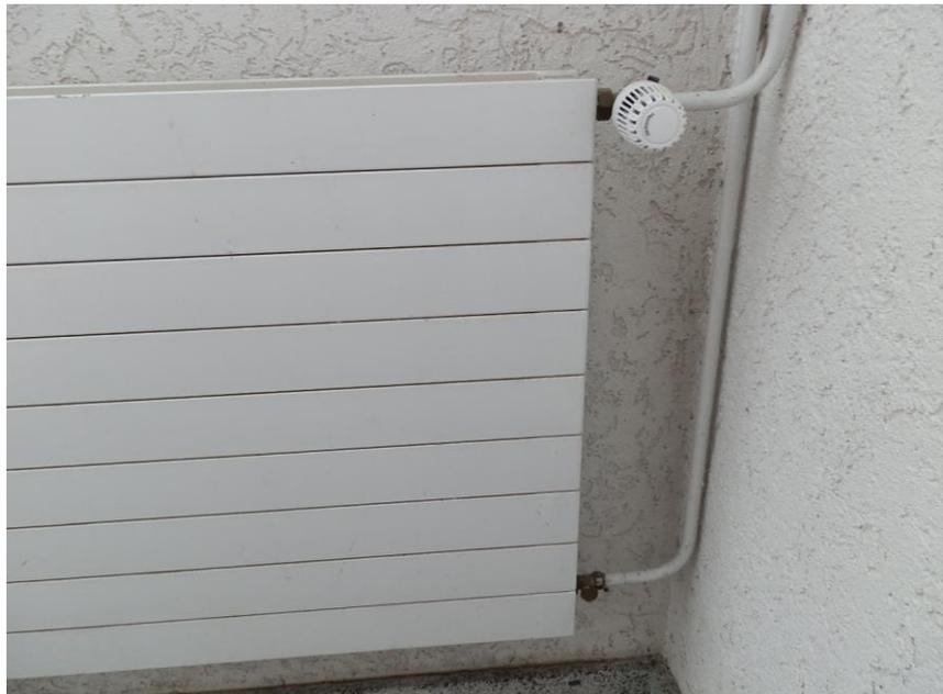
**Foto: Heizkörper mit altem Thermostatventil**
