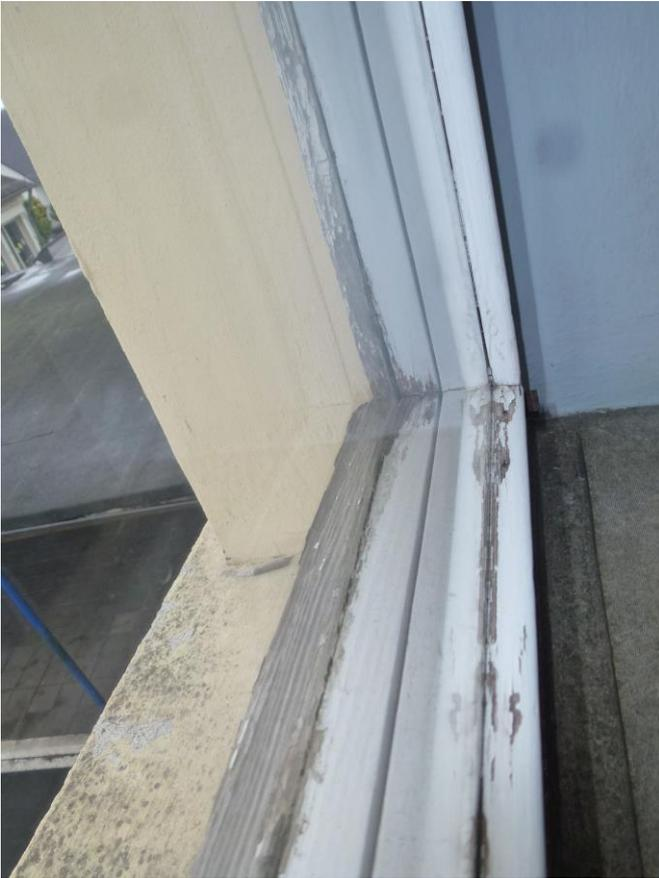
**Foto: Fenster Verbundglas, undicht**
