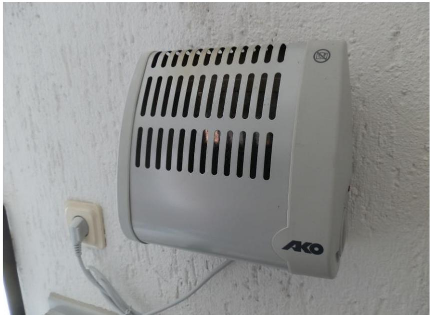
**Foto: Aufenthaltsraum OG/Elektro-Direktheizgerät**
