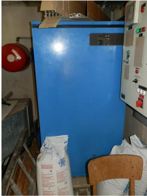
Foto: zentrale Trinkwassererwärmung
