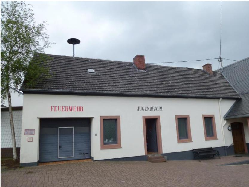
**Foto:** altes, ungedämmtes Dach**Außenwände**U-Wert gemäß Bauteilkatalog: Altbau: 1,0/Neubau: 0,5 W/(m<sup>2</sup> · K) [Sollwert gemäß EnEV = 0,24 W/(m<sup>2</sup>·K)]**12.** Art und Aufbau der Außenwandkonstruktion: Einschalig massiv  Zweischalig massiv  Fertigbauteile  Fachwerk Skelettbauweise [ ausgemauert]  Holzständerbauweise  Metallständerbauw. Sonstige:**12a.** Wandstärke: 30 bis 60 cm
