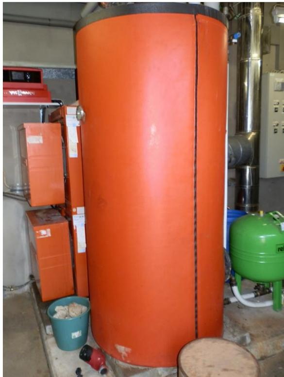
**Foto: zentrale Trinkwassererwärmung**
