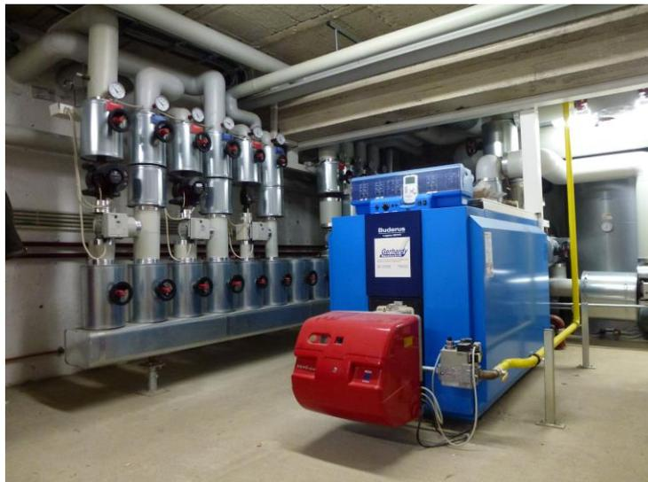
Foto: Heizkessel mit Erdgasfeuerung
