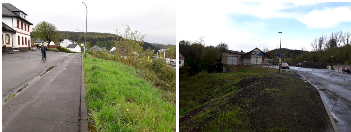
Abb.: Bilder der örtlichen Bestandssituation (eigene Aufnahmen, 18.05.2021)
