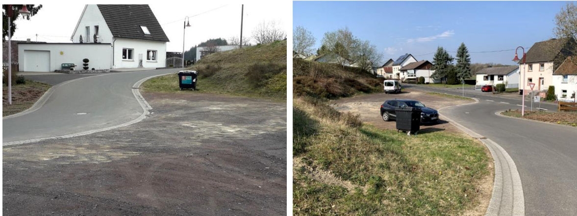
Abb. Bilder der örtlichen Bestandssituation zur geplanten Verkehrsfläche „Buswendeplatz“ (eigene Aufnahmen, 03.04.2020 (Foto links) und 09.04.2020 (Foto rechts))
