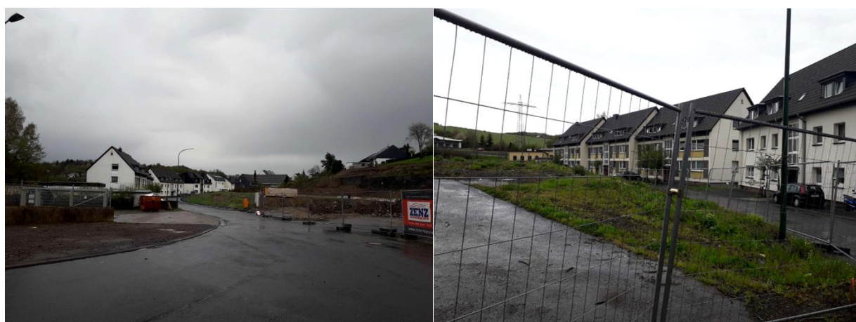
Abb.: Bilder der örtlichen Bestandssituation (eigene Aufnahmen, 18.05.2021)
