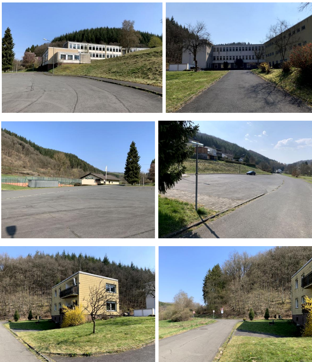
Abb.: Bilder der örtlichen Bestandssituation (eigene Aufnahmen, 09.04.2020)
