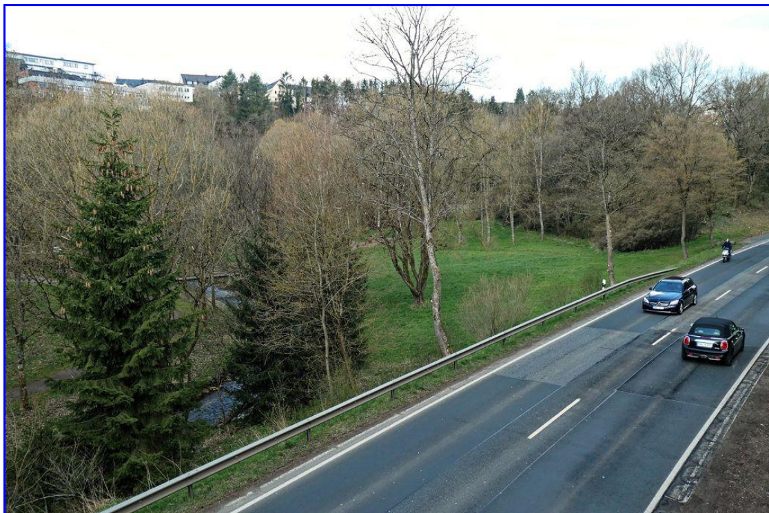
Abb. 11: Blick auf den Südteil des UG, links der B 257
